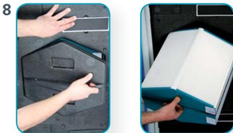
**Hinweis:** Beim Wiedereinbau den Wärmetauscher wieder so einsetzen wie ausgebaut.
