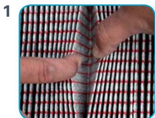
Zur Kontrolle der Außenluft- und Abluftfilter drücken Sie die Filterlamellen leicht auseinander und überprüfen Sie die Filterlamellen auf Verschmutzung.
